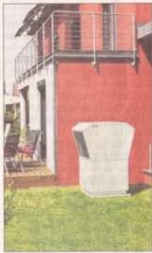
Über solche Kästen vor dem Haus wird Luft zur Wärmege- winnung angesaugt. Foto: BWP
