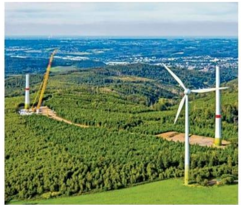
Bau von Windkraftanlagen in einem Waldgebiet.
