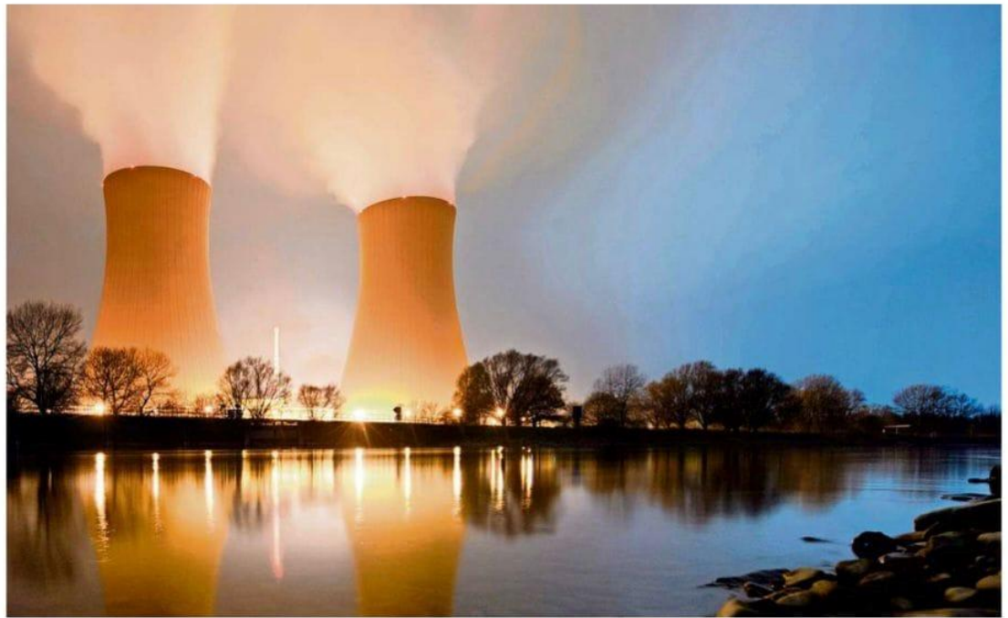
Von weit her sichtbar sind Atomkraftwerke wegen ihrer eindrucksvollen Kühltürme, aus denen Wasserdampf emporsteigt. In Deutschland ist seit April dieses Jahres kein Atomkraftwerk mehr in Betrieb.
